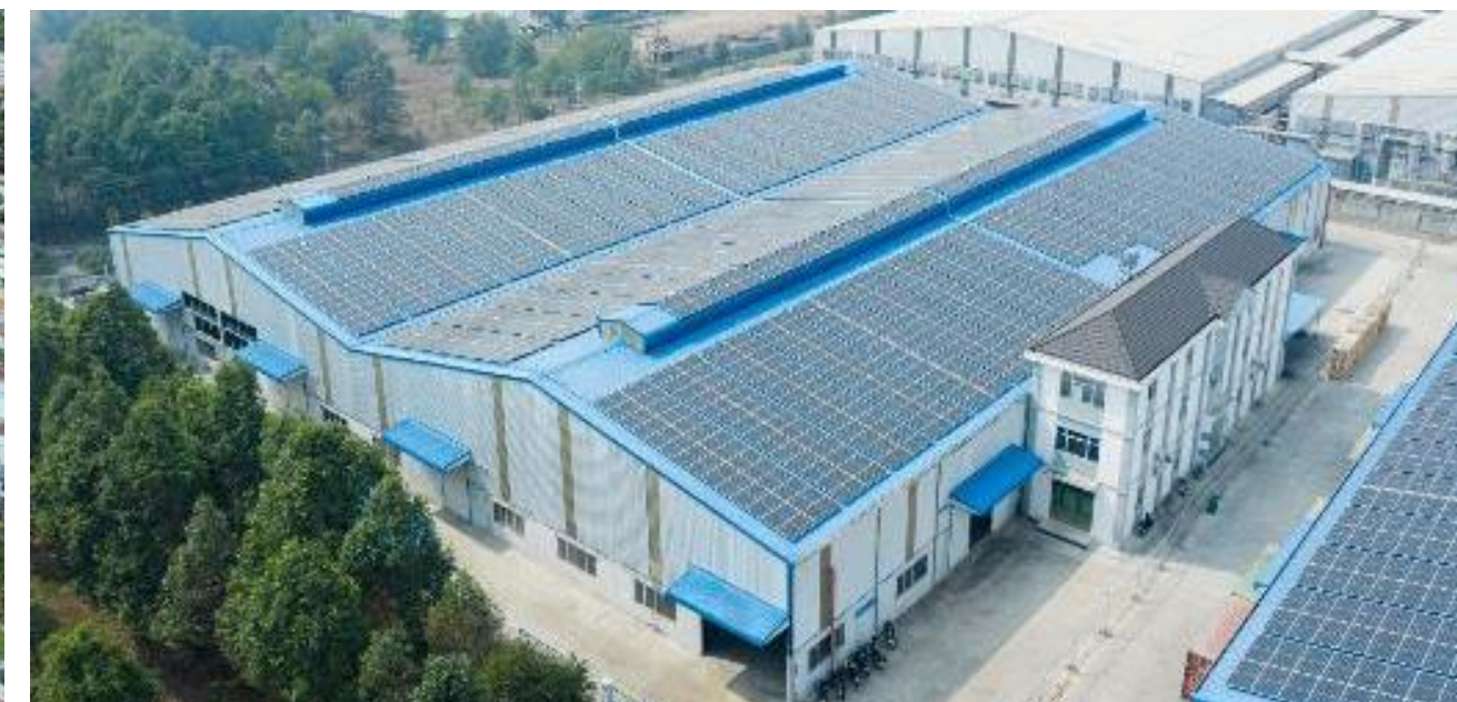
Ngan Hoang Phat, My Phuoc | 2,104 kWp
