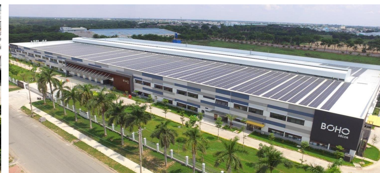
Boho Décor, Long An | 996.77 kWp
