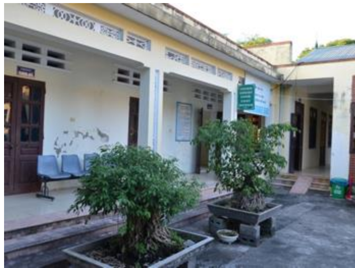
Trạm y tế
