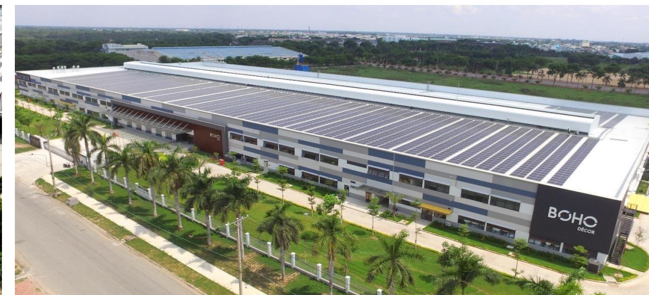
Boho Décor, Long An | 996.77 kWp
