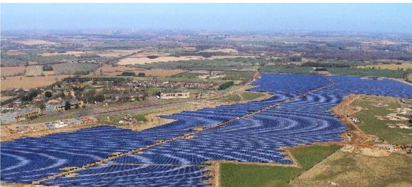
太陽能源 – 365 兆瓦(MW)
