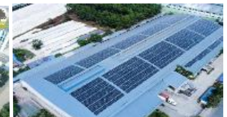
Fabtek, Bình Dương | 1,105 kWp
