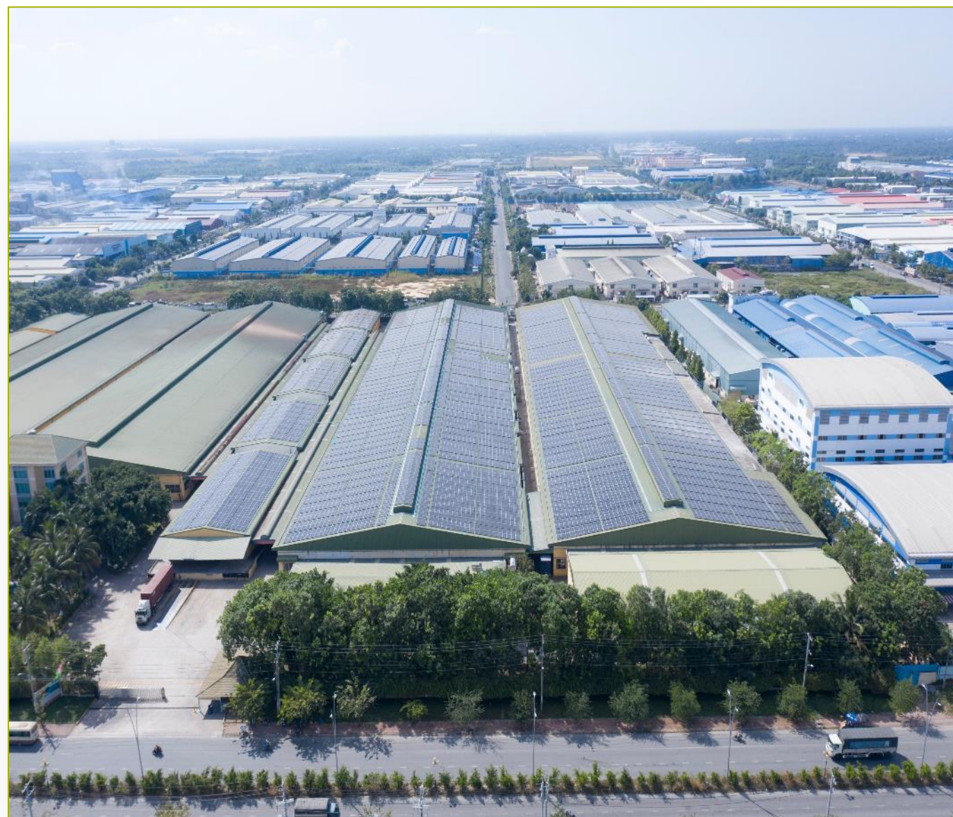
Điện mặt trời trên mái nhà
