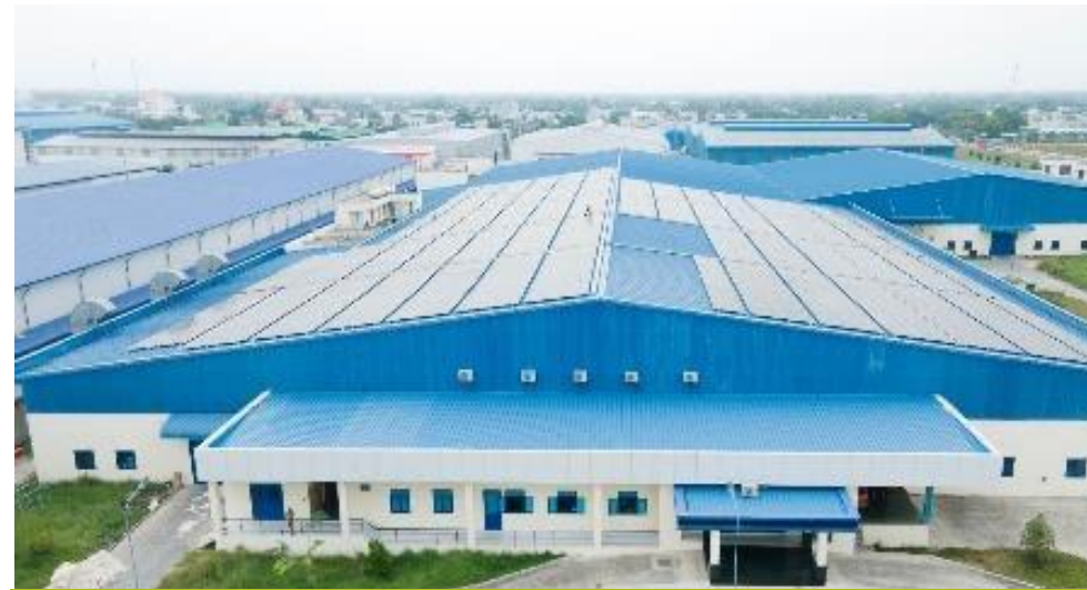
Việt Phú, Long An | 999.68 kWp
