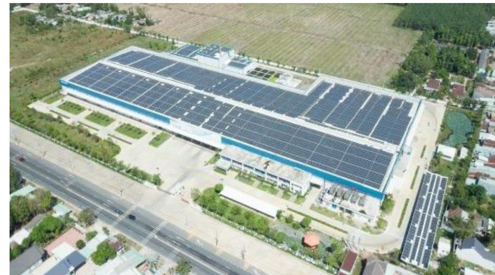
Tanifood, Tây Ninh | 5,125 kWp
