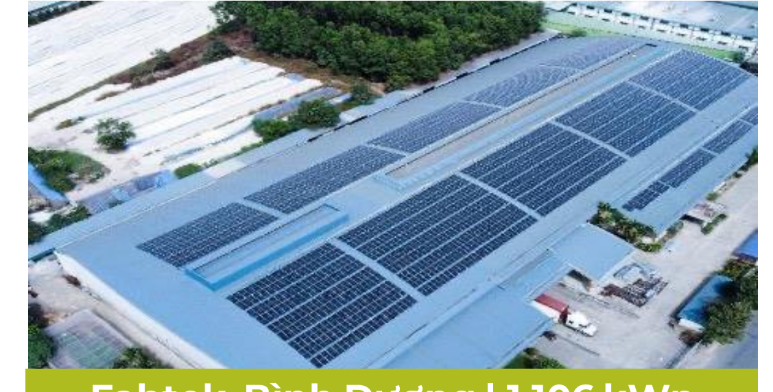
Fabtek, Bình Dương | 1,106 kWp
