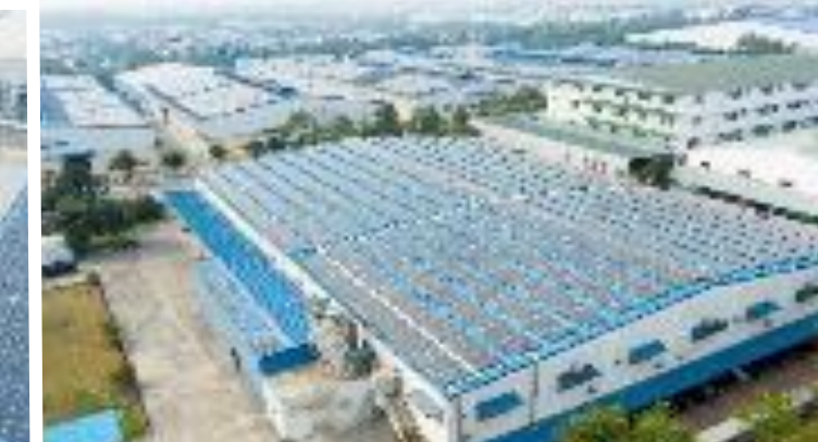
Daigaku, Bình Dương | 421 kWp
