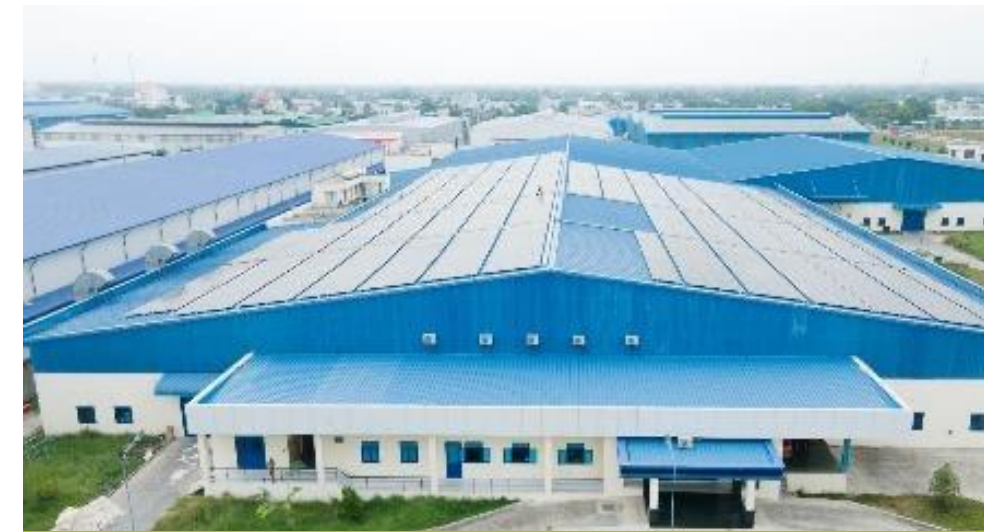
Việt Phú, Long An | 999.68 kWp
