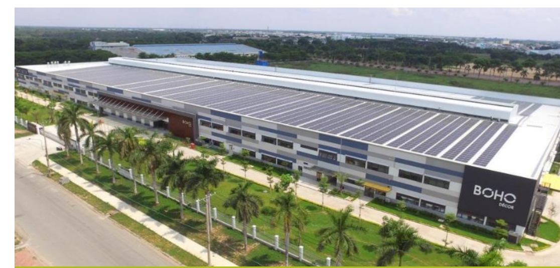
Boho Décor, Long An | 997 kWp
