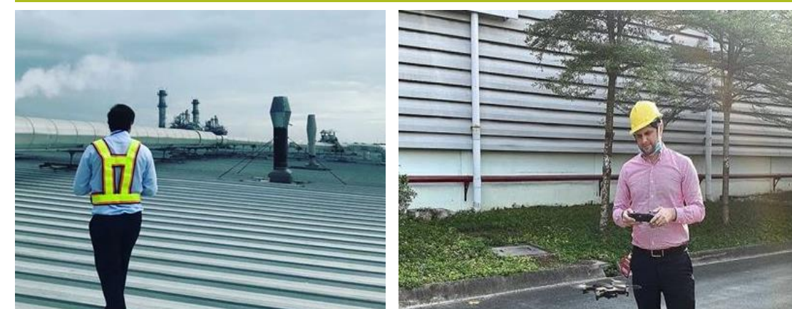
Kiểm tra lưới và khảo sát mái bằng drone
