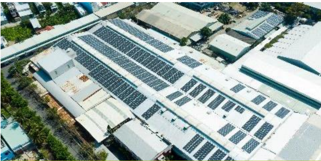
Mekong Tiền Giang | 891 kWp
