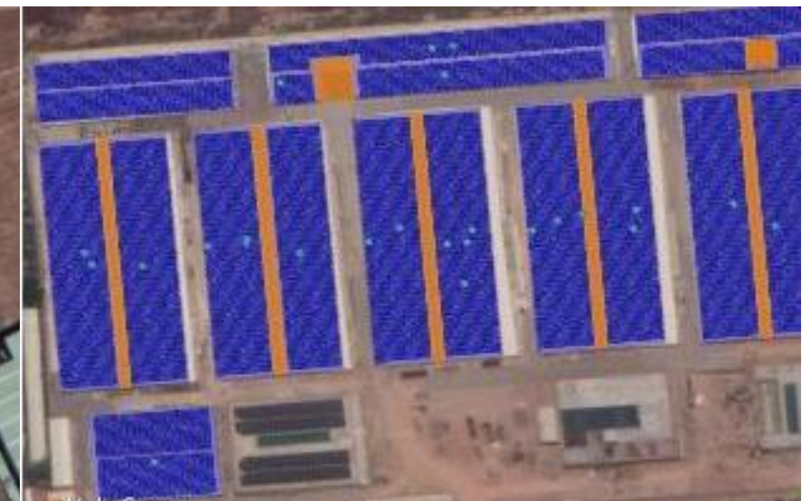
Chinli Plastic, Bình Dương | 3,200 kWp
