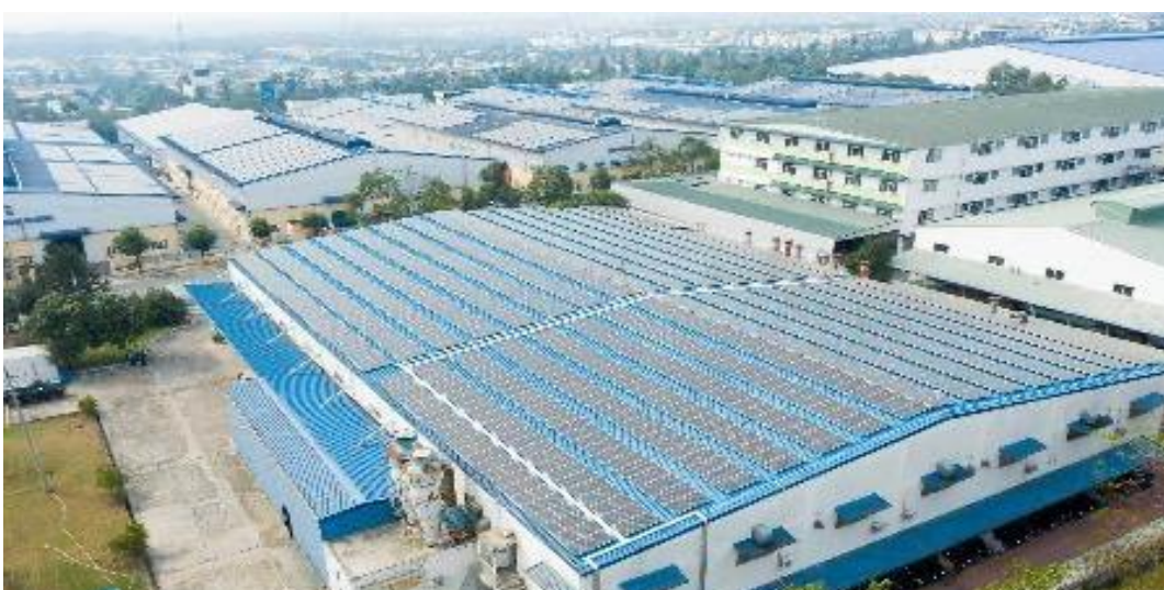
Daigaku, Bình Dương | 422 kWp
