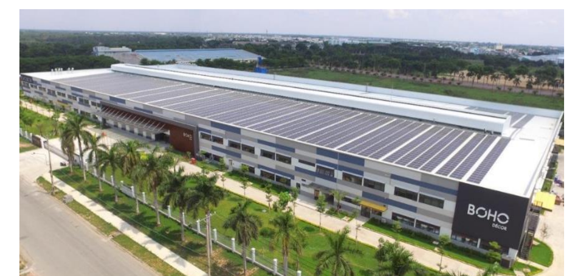
Boho Décor, Long An | 997 kWp
