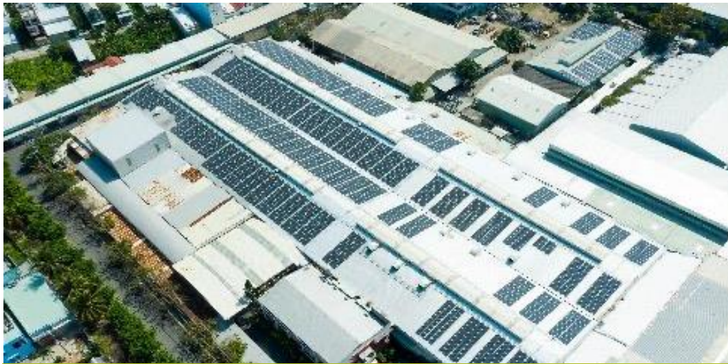
Mekong Tiền Giang | 891 kWp
