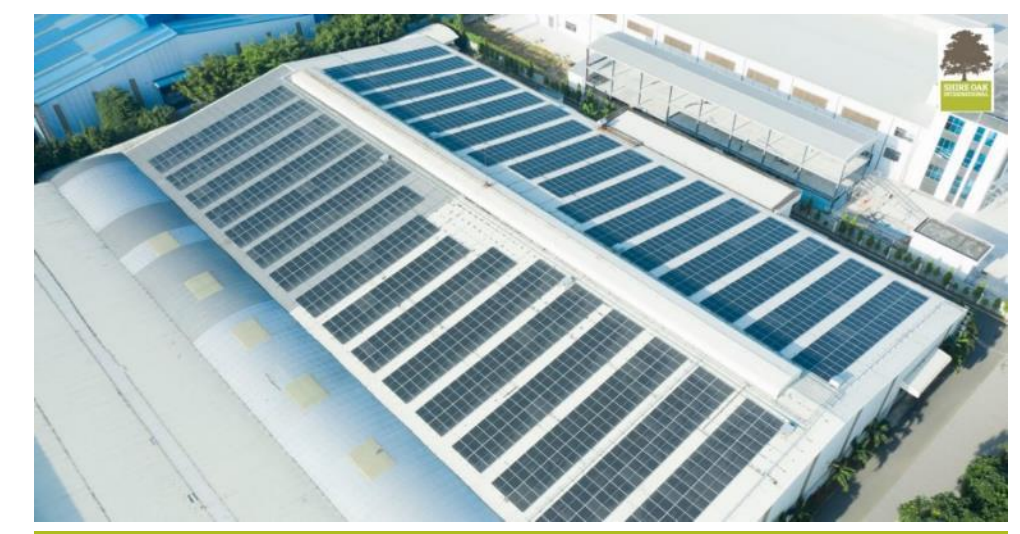
Mekong Bến Tre | 769 kWp
