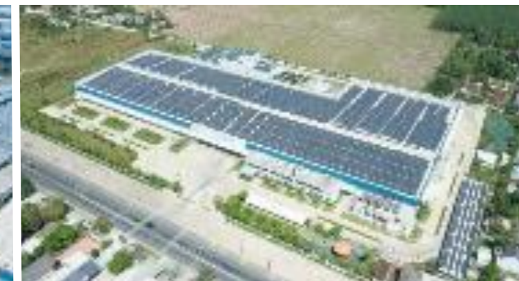
Tanifood, Tây Ninh | 5,125 kWp
