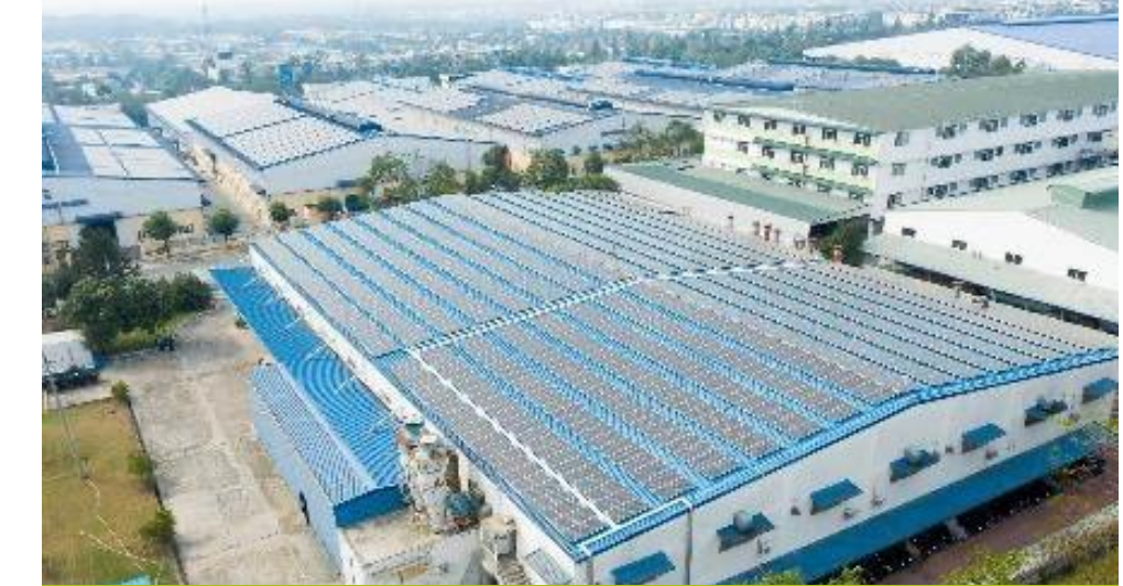
Daigaku, Bình Dương | 422 kWp
