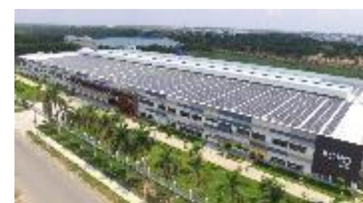
Boho Décor, Long An | 996 kWp
