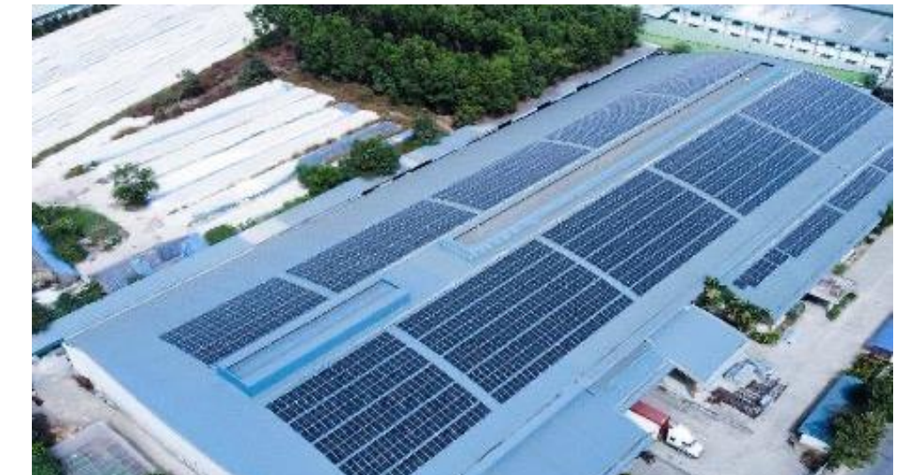
Fabtek, Bình Dương | 1,106 kWp
