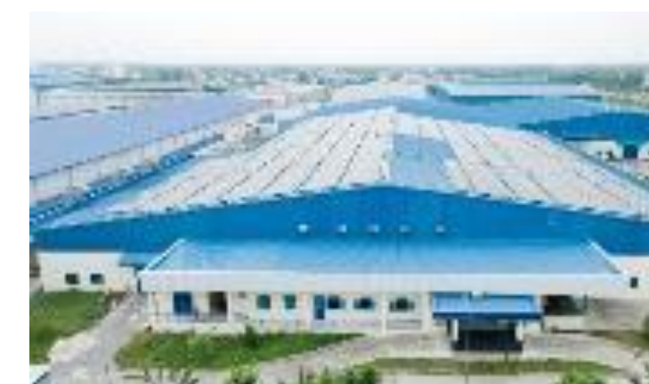
Việt Phú, Long An | 999.68 kWp
